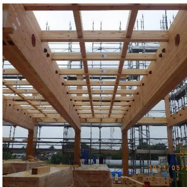
住宅用プレカット工場から出荷された木材で施工
