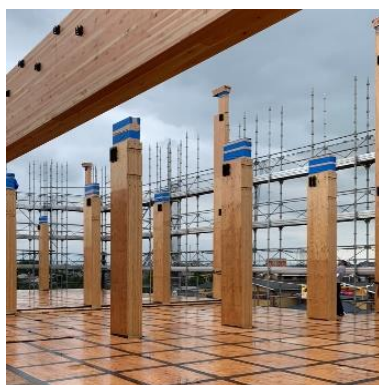
床 (住宅用の合板をビル用へと展開し 木造の職人による施工)
