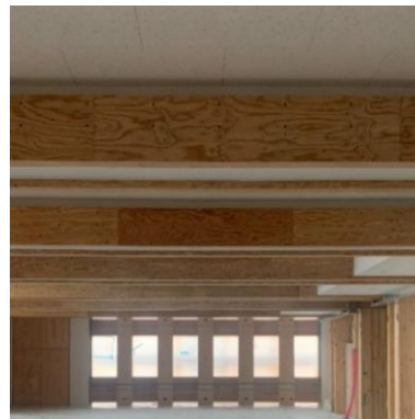
相欠き合わせ柱式ラーメン 大きな開口部を設けながらも 住宅用耐力壁の 8 倍
