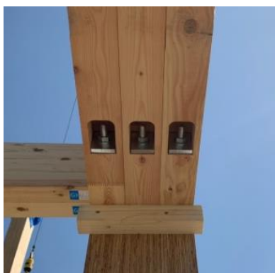
柱、梁 (住宅用の構造材 3 本を組合せて ビル用の柱・梁の構造体へ)
