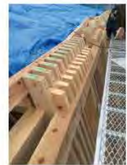
屋根格子/壁格子 桁材を介して軸力を伝達
