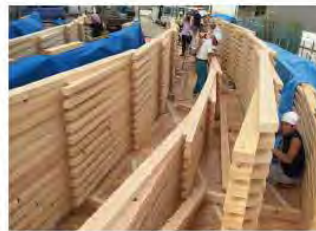
屋根格子ユニット(屋根版)の敷設状況 長9m、巾1.38mのユニット毎に吊り上げて配置した
