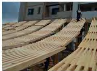
現場加工・組み立ての屋根格子ユニット 一般大工の手によって十分な精度が得られた
