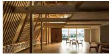
1階ショールーム 2mの横面軸組をあらわし、梁間方向スパンは7m
