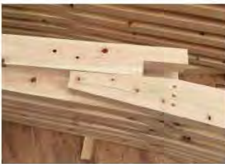
屋根格子の接合部 ビス位置をずらし、干渉や割裂を防いだ
