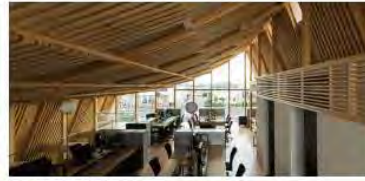
2階事務室 屋根は流通小径材による湾曲版構造。9mスパンの無柱空間
