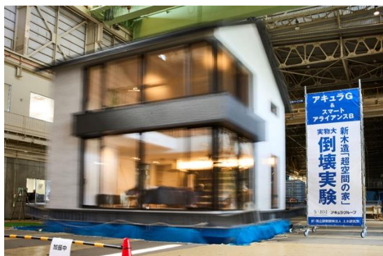
「実物大倒壊実験」を実施し倒壊しないことを実証
