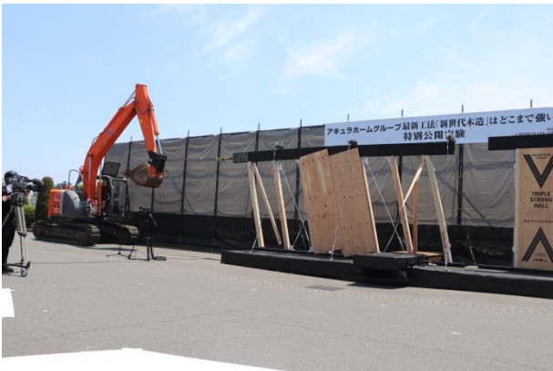
6枚の従来型耐力壁は重機の動きにあえなく傾き、そのまま破壊された。 6枚で耐力61kNを計測
