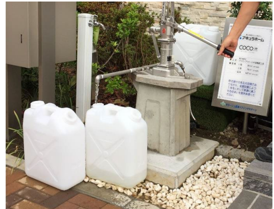
井戸水をくみ上げて供給する様子
