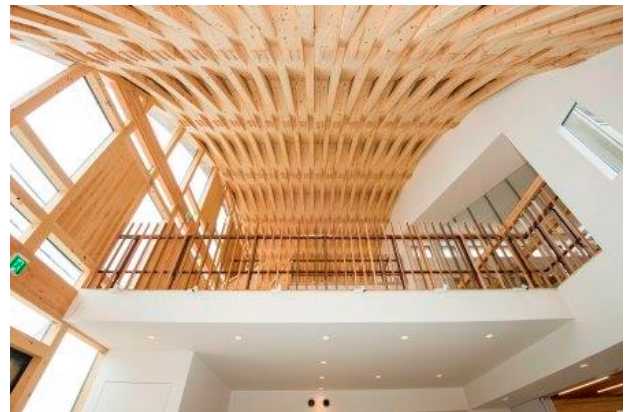
「住まいと暮らしサロン」室内から見た「シザーストラスアーチ」
