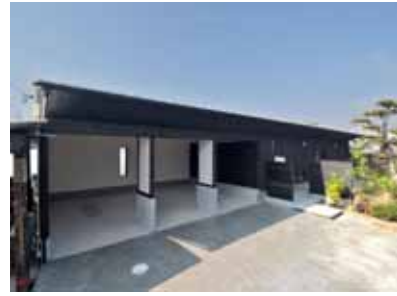
明石建設(株) (香川県坂出市)
