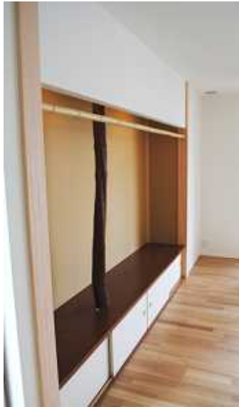
写真は「良母(りょうぼ)」の床柱
